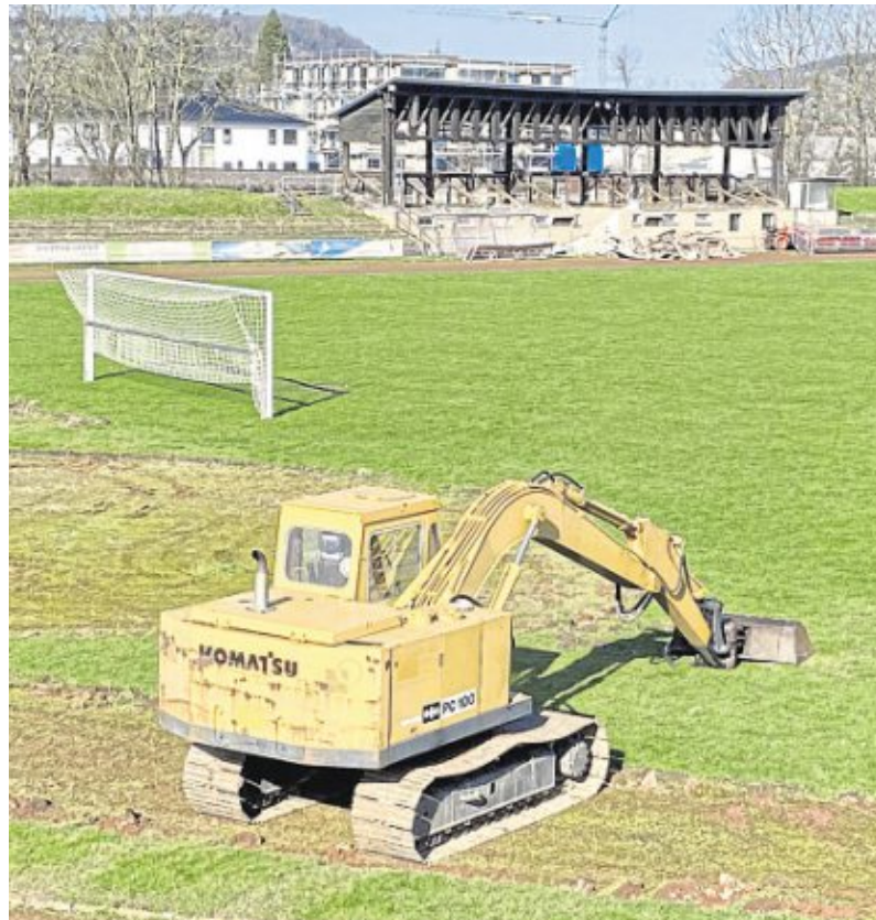
Noch reicht die Infrastruktur nicht zur Erstklassigkeit, doch es tut sich was in Andernach: Bis zur neuen Saison soll die alte Holztribüne instand gesetzt sein und dann rund 350 Zuschauern Platz bieten. Außerdem bedarf es einer Flutlichtanlage und eines erneuerten Rasens.
